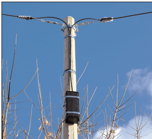
Slika 9. Nastavak ADSS kabla na stubu
