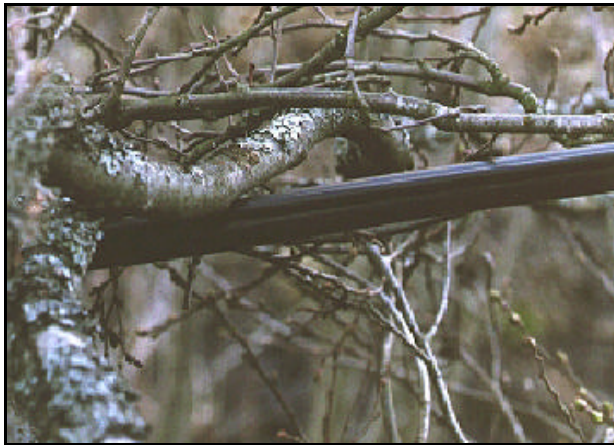
Slika 8. Instalisanje slaboizolovanih provodnika
